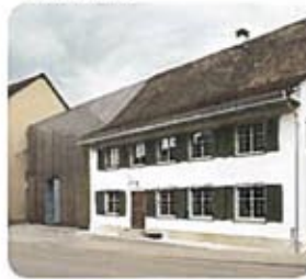
brand.3 Architektur, Winterthur Umbau/Erweiterung Bauernhaus, Lönnigen SH
