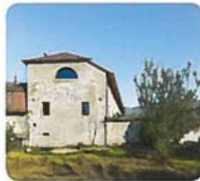
Charles Pictet Architecte, Genf Umnutzung Kornspeicher, Landecy GE
