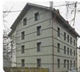
Kast Koeppli Architekten, Bern Sanierung/Umbau Mehrfamilien- haus, Bern BE
