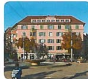
Schaffner Architekt, Zürich Sanierung/Umbau Genossen- schaftssiedlung, Zürich ZH
